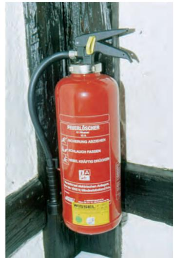
Abb. 8: Der hier bereitgestellte Wasserlöscher ist neben dem Küchenbereich positioniert. Beim Löschen von Fettbränden hätte dies fatale Folgen. Der Wasserdampf würde dann heißes, eventuell brennendes Fett/Öl aus dem Becken herausschleudern und Personen gefährden.
