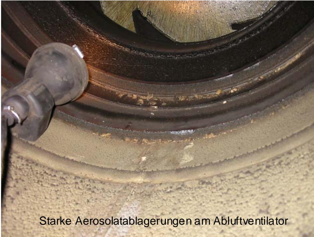
Starke Aerosolablagerungen am Abluftventilator
