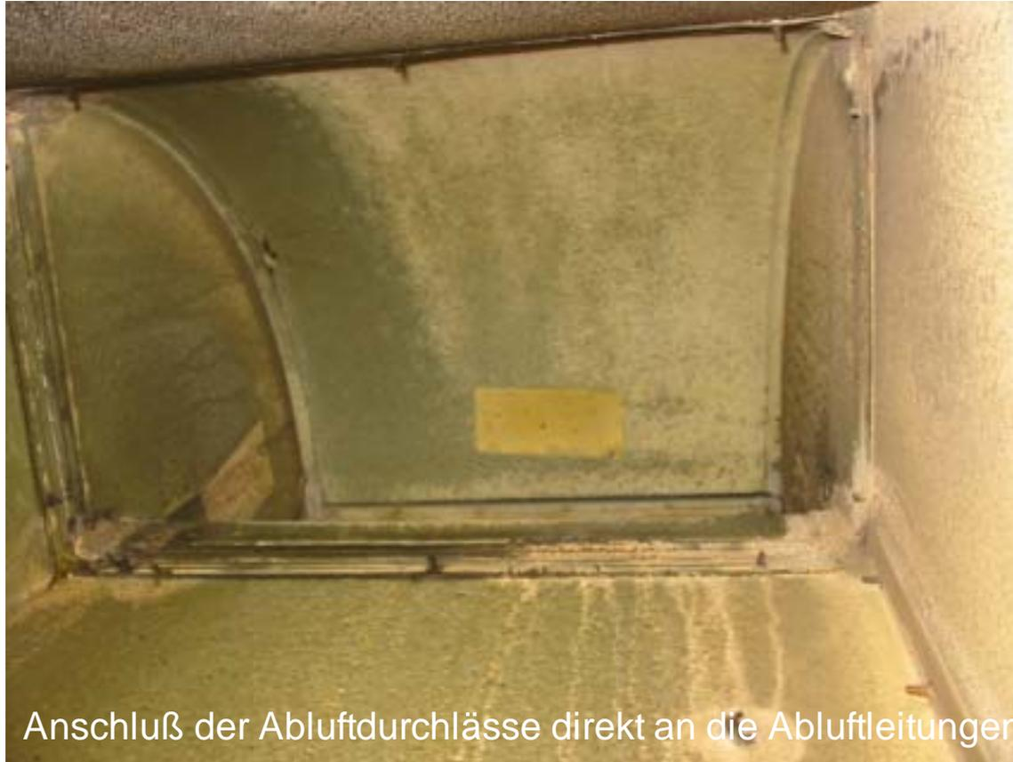
Anschluß der Abluftdurchlässe direkt an die Abluftleitungen
