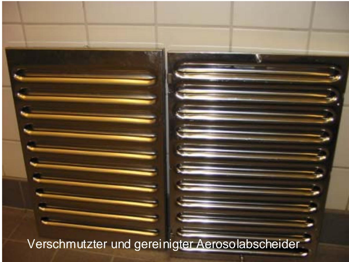
Verschmutzter und gereinigter Aerosolabscheider
