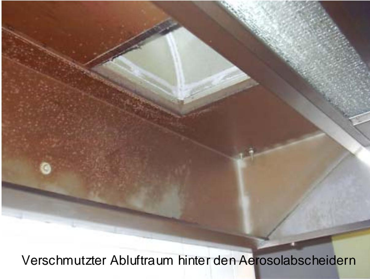
Verschmutzter Abluftraum hinter den Aerosolabscheidern
