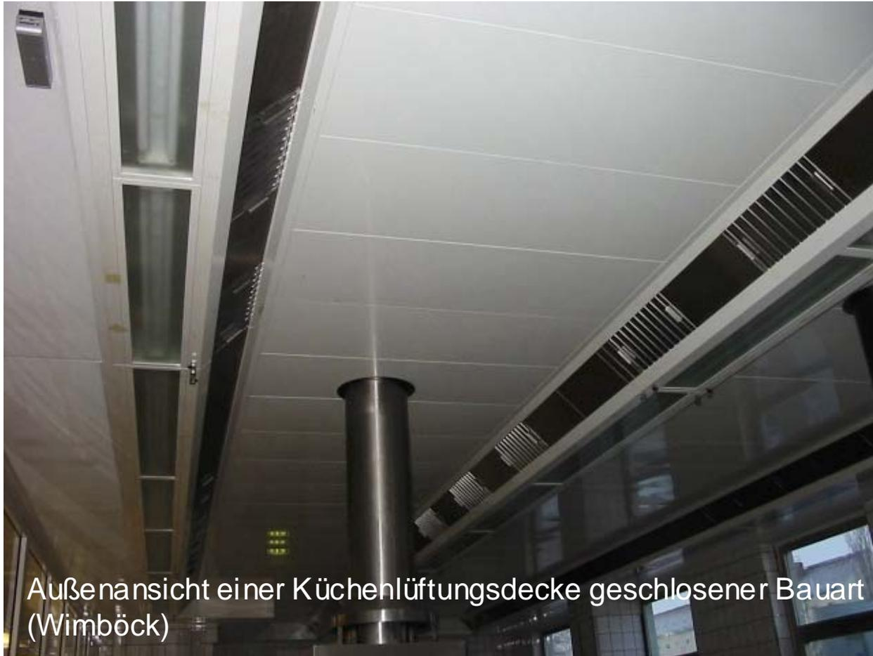
Außenansicht einer Küchenlüftungsdecke geschlossener Bauart (Wimböck)
