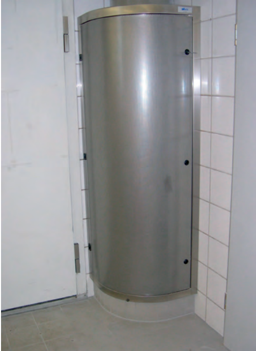
Abb. 9: Optimal ist die Zuluftein- bringung mittels Quellluftdurchlass.
