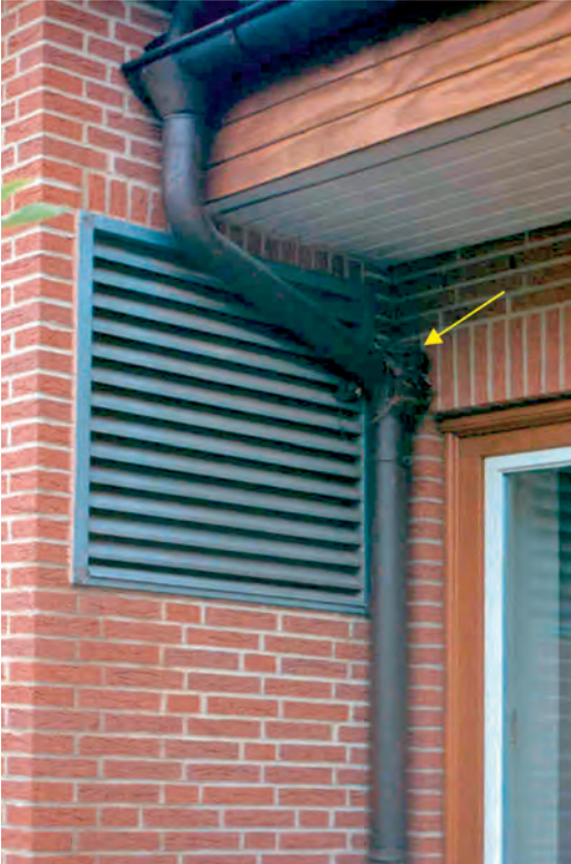
Abb. 4: Hygienisch problematischer Außenluftdurchlass. Das Fallrohr ist Schmutzfänger und bietet Nistmöglichkeiten für Vögel (siehe Pfeil).
